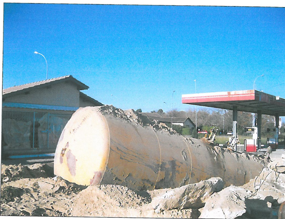
Figure n°8 : Démantèlement de la cuve de stockage de 75 m 3 .
